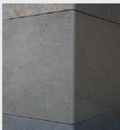
Finitura con piastrelle a battuta Standard sit-on outcorner
