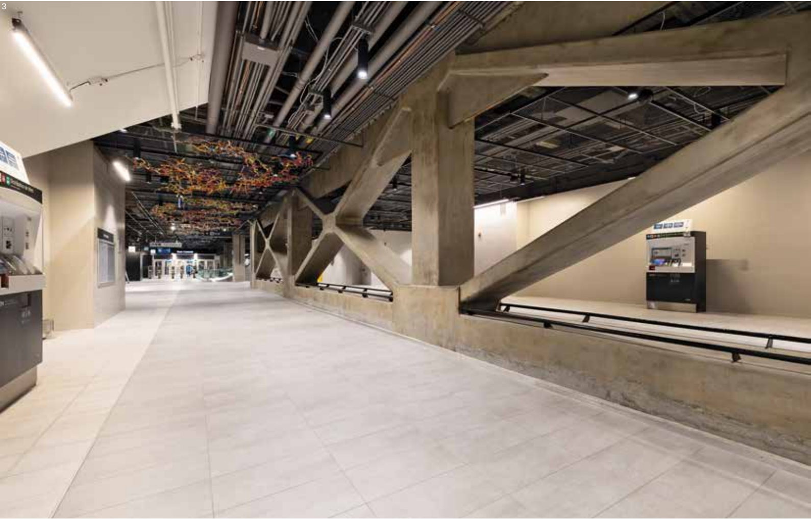
1 vue du quai avec revêtements de sol et revêtements muraux en grès cérame Ansicht des Bahnsteigs mit Bodenbelägen und Wandverkleidungen aus Feinsteinzeug 2, 3 vue des passages surélevés et souterrains menant aux quais Blick auf die oberirdischen und unterirdischen Verteilerwege zu den Bahnsteigen
