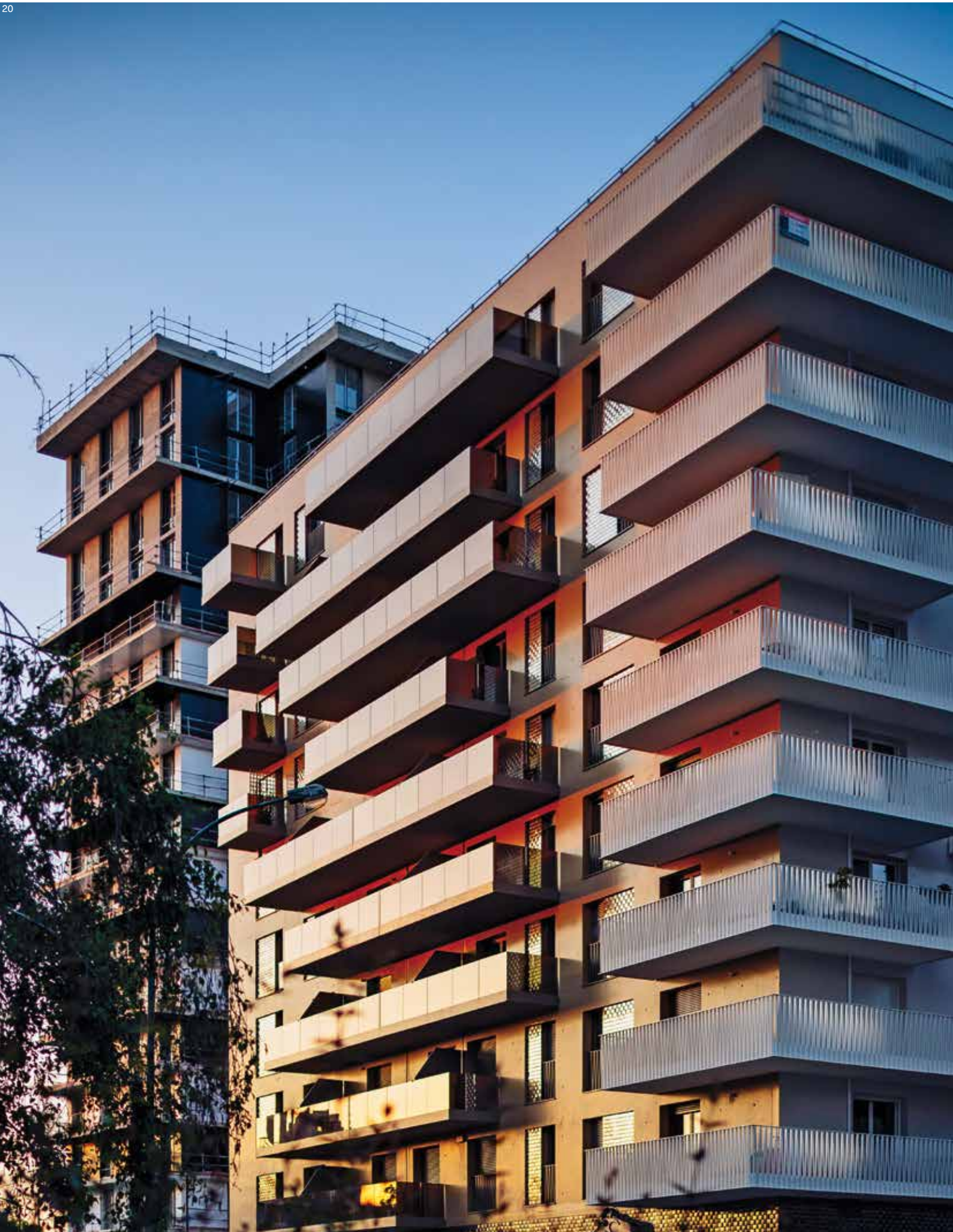
20 vue d'angle du bâtiment résidentiel Eckansicht des Wohngebäudes
