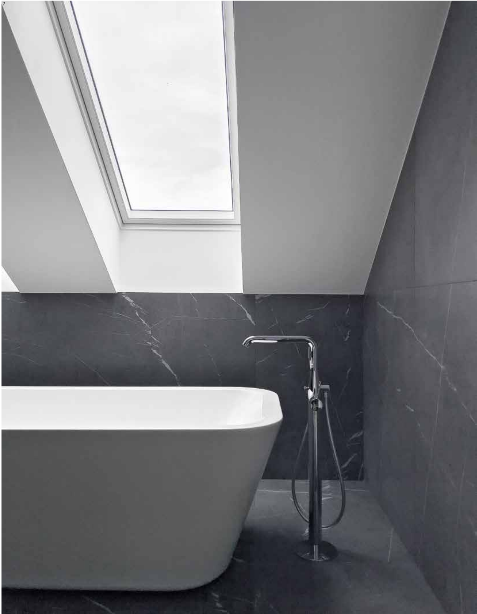
4-7 la salle de bains, vues d'ensemble et de détail du revêtement en grès cérame Badezimmer, Gesamtansicht und Detailansicht der Wandverkleidung aus Feinsteinzeug
