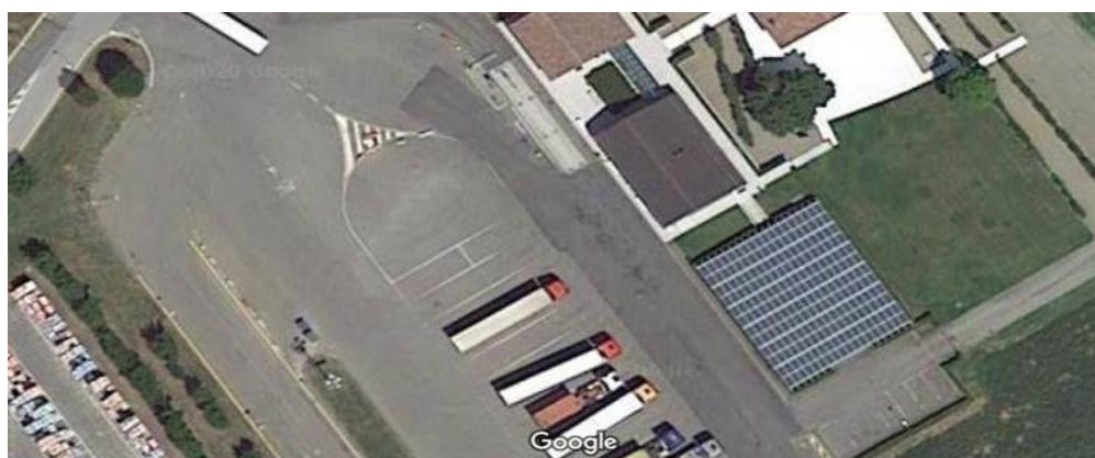
Figura 34 - Impianto fotovoltaico Sede centrale
