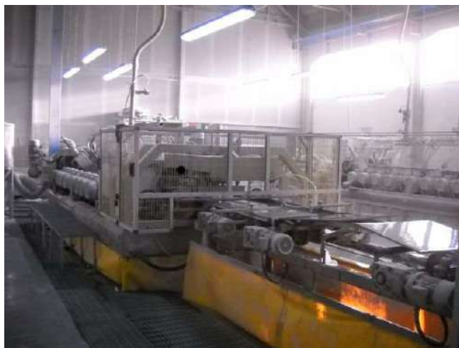
Figura 10 - Linea di levigatura dello stabilimento di Dinazzano
