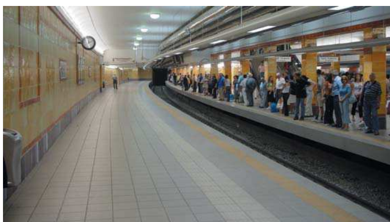
Figura 44 - Linea Metropolitana di Atene, ristrutturata in occasione delle Olimpiadi del 2004; per la pavimentazione delle banchine sono stati utilizzati gli elementi in grès porcellanato della serie Tactile di Casalgrande Padana.
