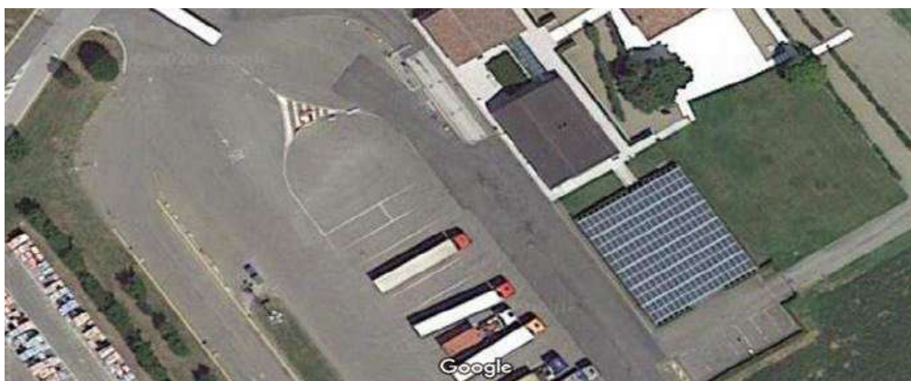
Figura 38 - Impianto fotovoltaico Sede centrale
