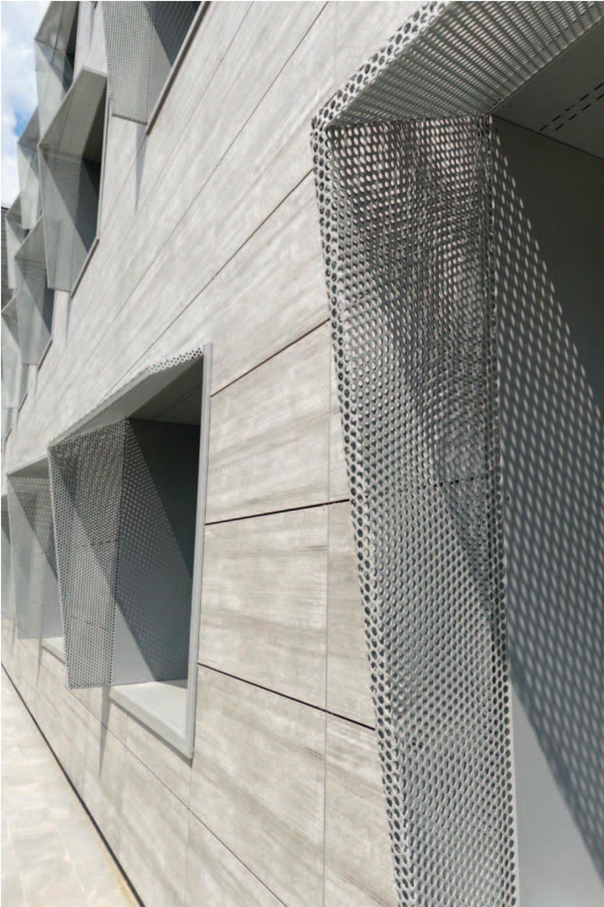
Ospedale di Lugo Lugo di Ravenna, Italia Ufficio Tecnico AUSL Romagna Cemento: Cemento Cassero Grigio, Cemento, Cassero Antracite cm 60x120
