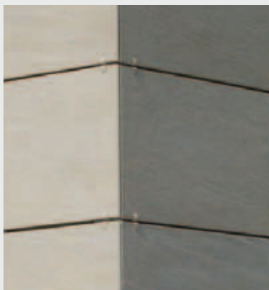
Angle sortant avec un bord arrondi Ausführung mit einseitig abgeschrägter Kante
