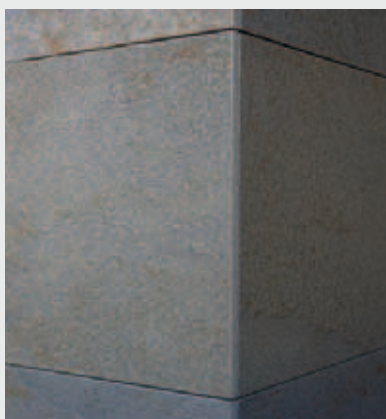
Angle sortant en appui Ausführung mit Stoßkanten
